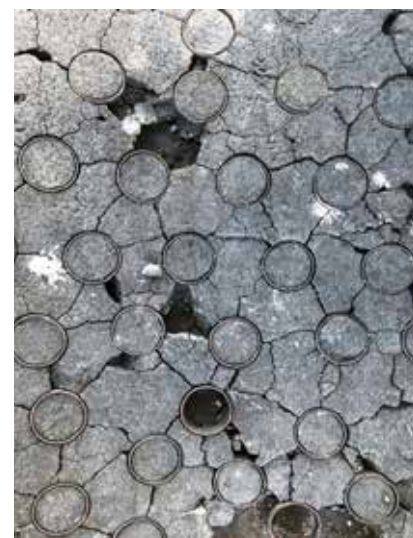
部分的に欠落したライニング
